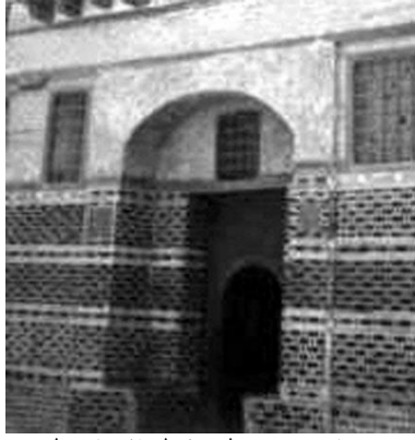
شكل رقم ٦ باب و مدخل منزل الاماصيلي و تبدو به الخوخة (من مباني العصر العثماني)
