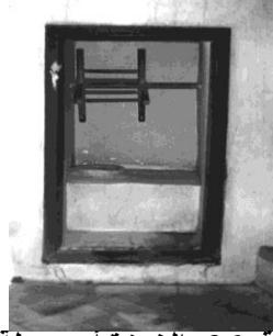
شكل رقم 26: الخرزة أو وسيلة جلب المياه للأدوار العلوية.
