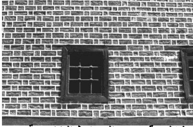
شكل رقم 29: الحوائط الخارجية من الطوب المحروق مع فواصل خشبية.
