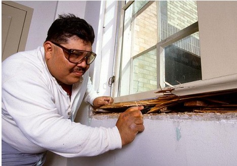
شكل رقم 6 جلسة أحد الشبابيك و قد تآكلت بسبب النمل الأبيض
