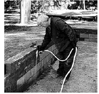
شكل رقم 9 يجب رش الردم أسفل و حول المبني بمواد مكافحة النمل الأبيض.
