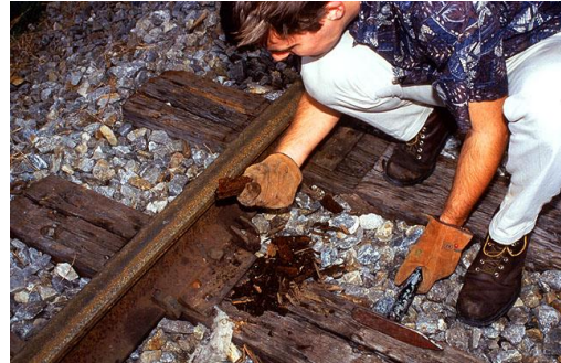
شكل رقم 5 فلنكات سكة حديدية و قد تآكلت تماما بفعل النمل الابيض.
